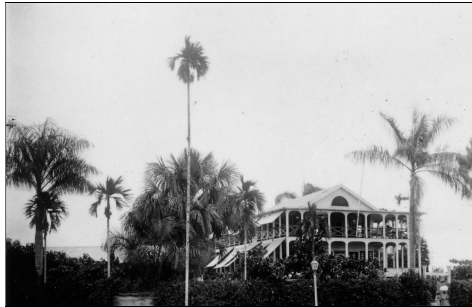
11. Buiten-Sociëteit 'Het Park'
